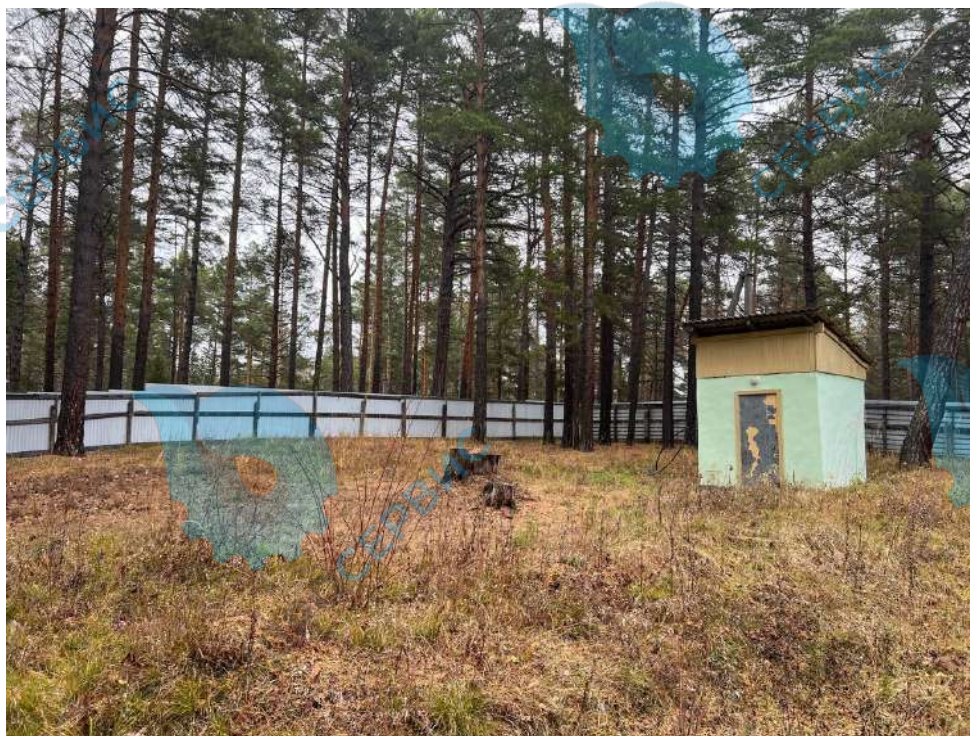
Рисунок 4. Сооружение над устьем скважины № 1
