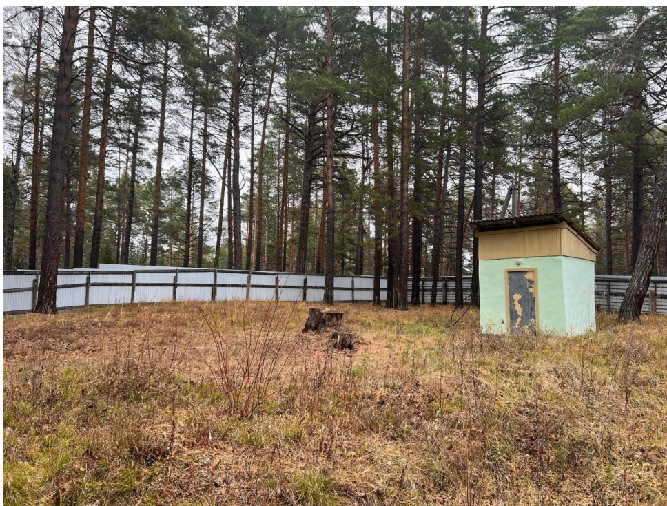
Рисунок 4. Сооружение над устьем скважины № 1
